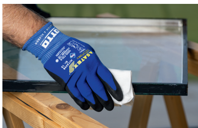
Reiniging van de randverbinding met OTTO Cleanprimer (dan wel cleaner + primer) 1) en stoffen doek.
