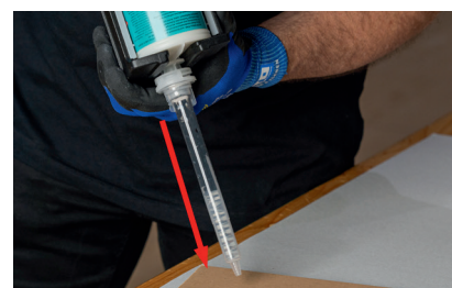
Vullen van de statische menger met lijm. Homogeniteit van het mengsel controleren (zie verwerking begeleidende kwaliteitscontroles 2K-producten)
