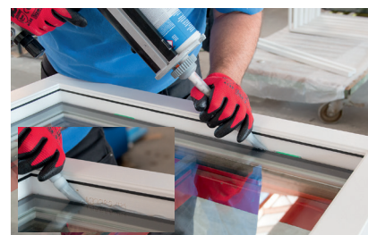
Sponning vullen met lijm
