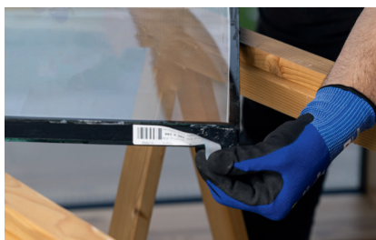
Verwijderen van stickers van het isolatieglas
