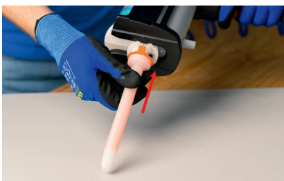
Materiaal afvegen en statische menger opzetten
